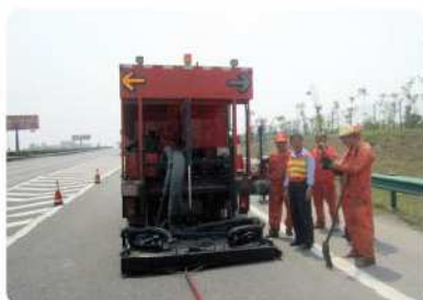
安徽阜阳线公路PM220施工现场
