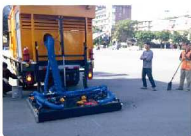
四川成都市区道路PM220施工现场
