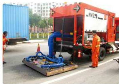
江苏常州新北区PM220施工现场
