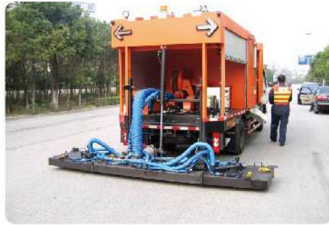
半刚性基层反射裂缝治理中
