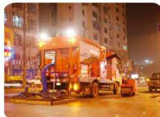
整车噪音小，夜间施工不扰民
