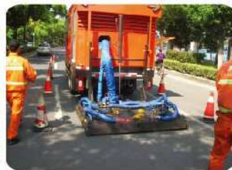
轻便灵活，适用于窄道、弯道施工
