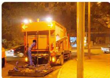
重庆市政道路PM220施工现场
