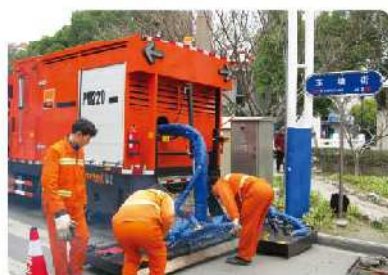
江苏苏州市区PM220施工现场
