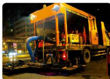
江苏南京市政道路PM220施工现场
