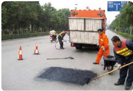
坑槽路病治理中
