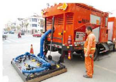
江苏靖江市政道路PM220施工现场
