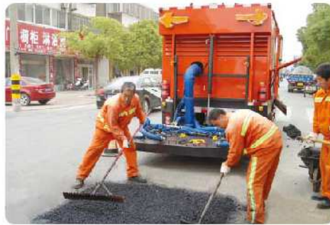
网裂路病治理中
