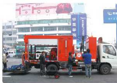
陕西西安PM220施工现场
