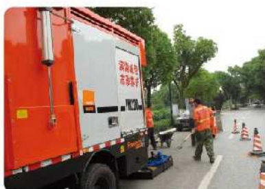
无锡市滨湖区道路PM220施工现场
